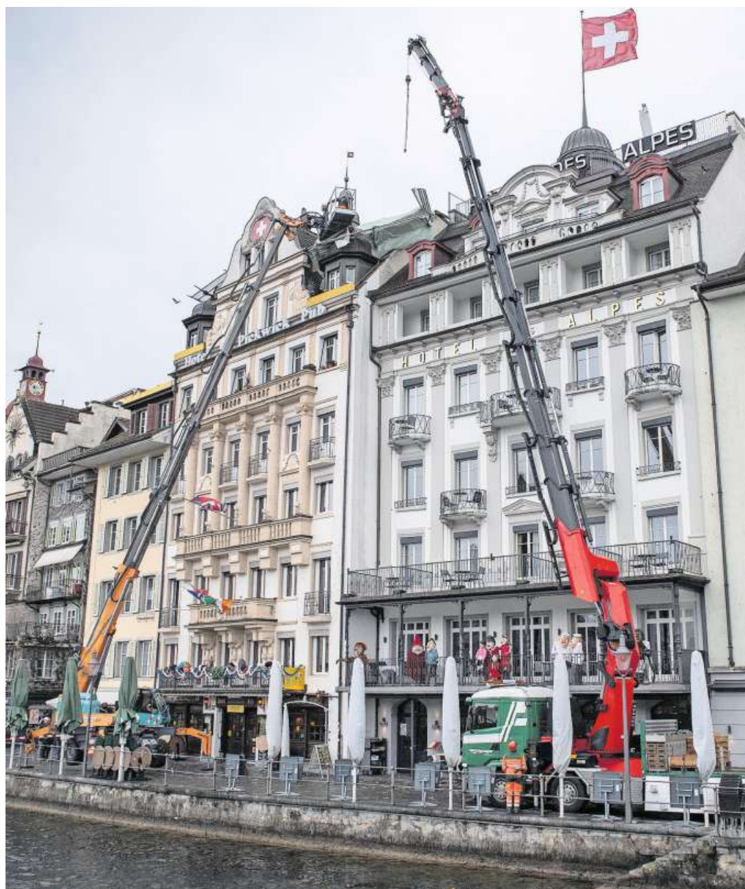
Auf dem Hotel Mr. Pickwick in Luzern wurde ein Baugerüst verschoben.
