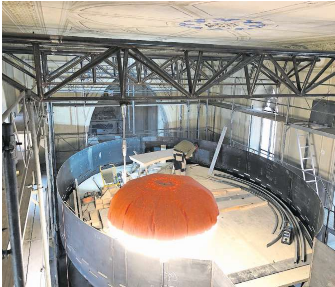
Ein erster Eindruck der frei hängenden Plattform im Kapellenschiff. Die Sanierungsarbeiten im Innern laufen noch bis Februar. Bild: PD
